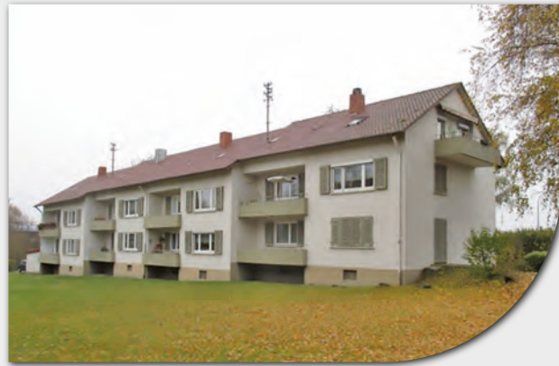
Auf Schmiden 168 vor der Sanierung
