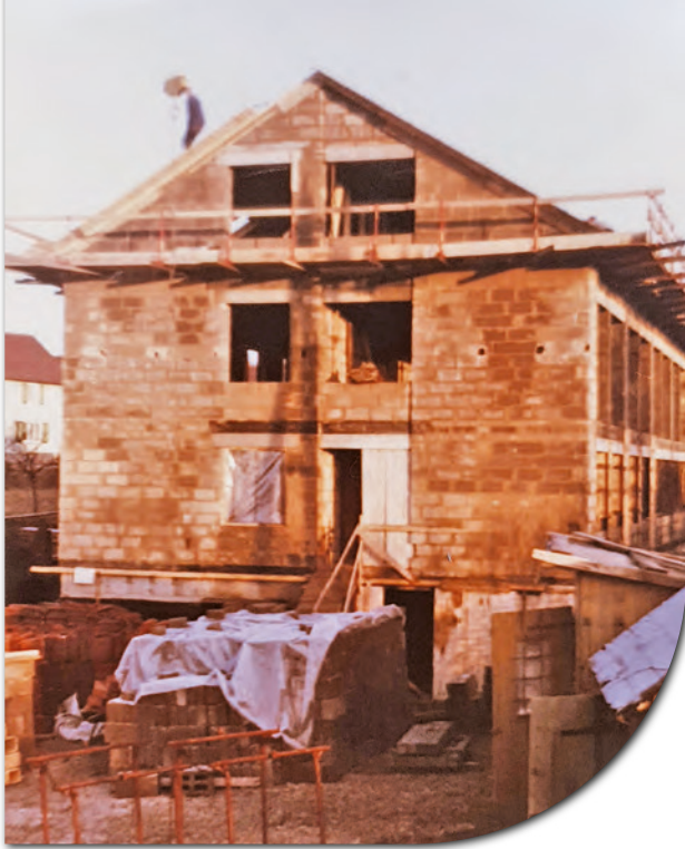
Bau des neuen Verwaltungsgebäudes in der Längenfeldstraße 21
