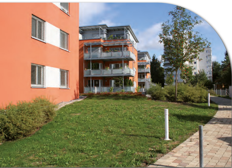
Passivhäuser, Bohnenbergstraße 2, Arnoldstraße 2 und 4
