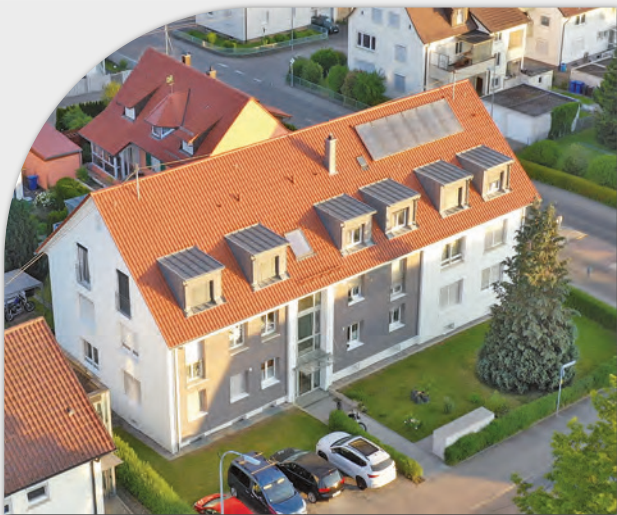
Nach der Sanierung, Längenfeldstraße 2, Johann-Sebastian-Bach-Straße 18
