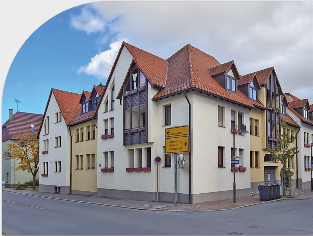
Schwanenstraße 12, Wilhelmstraße 41 und 43
