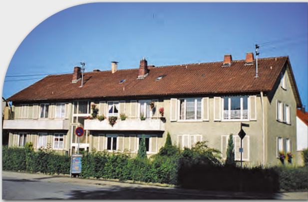
Vor der Sanierung, Längenfeldstraße 2, Johann-Sebastian-Bach-Straße 18
